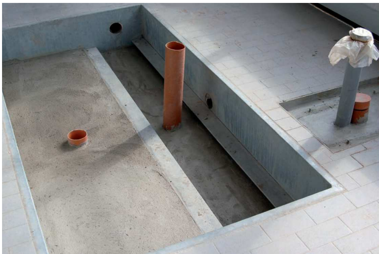
40. ábra: Aknabélés bebetonozva (példa)
